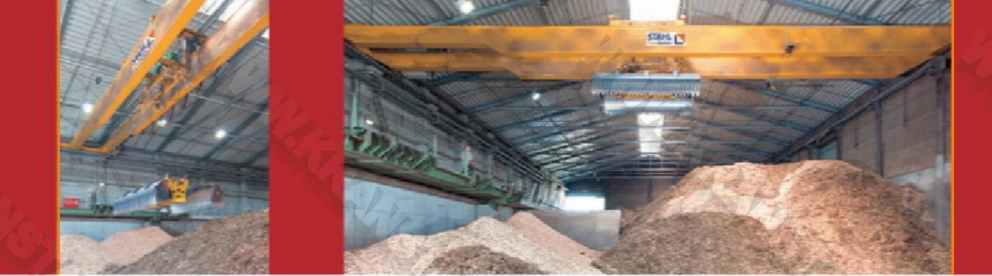
В зоне движения грузовиков (слева на рисунке) крановый мост специально смешен в сторону, чтобы можно было наклонять грузовики с высокими надстройками.
